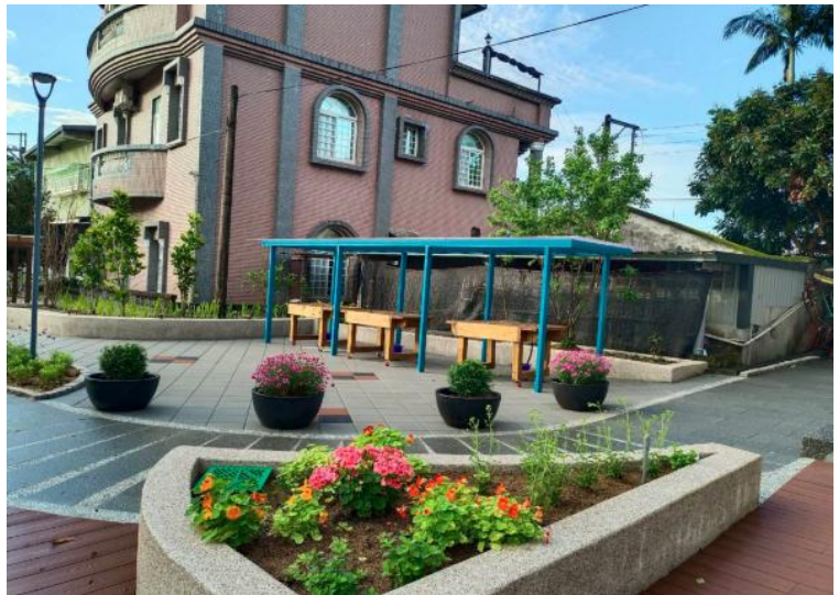
完工後的一樓花園：遮蔭花架與花卉植栽槽，讓曾經只是車道的庭院有了新的重心。（圖片來源：石佳蓉）
